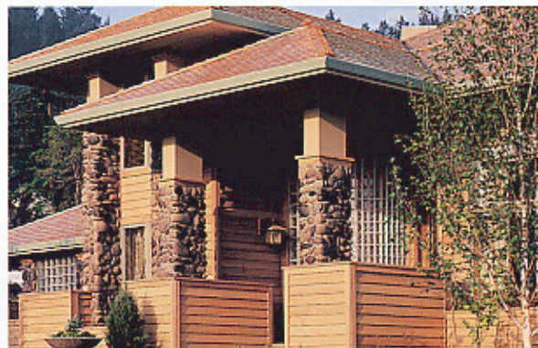
外壁サイディング
